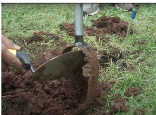
Gambar 6 Pembuatan Lubang Pemasangan Biopori
