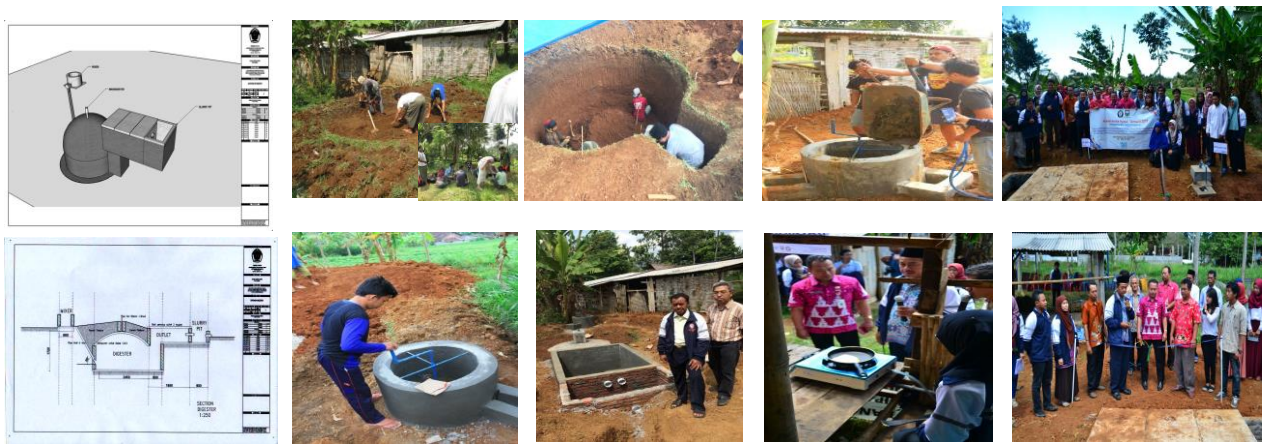
Gambar 1. Ilustrasi kegiatan gambar desain, pembangunan instalasi biogas, pengisian digester, uji coba kompor biogas dan peresmian instalasi biogas
