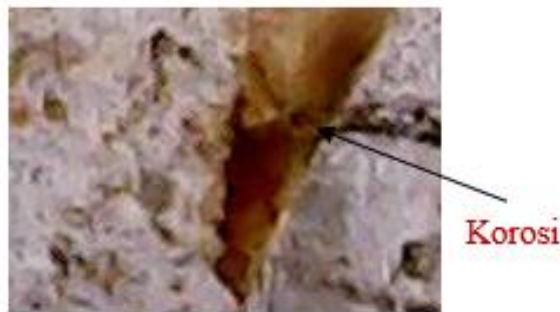
Gambar 3. Korosi yang tampak pada pelat anoda korban I pencelupan 48 Jam III
