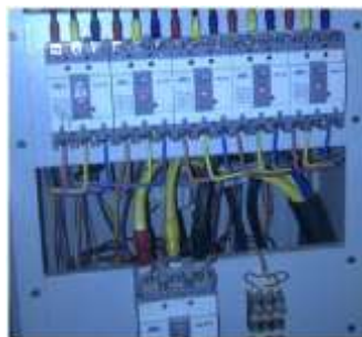
Gambar 3.2 Kapasitor bank 50 KVAR 5 step
