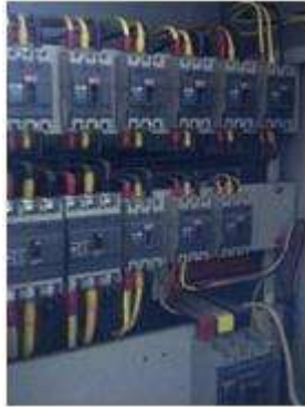
Gambar 3.1 Kapasitor bank 180 KVAR 6 step
