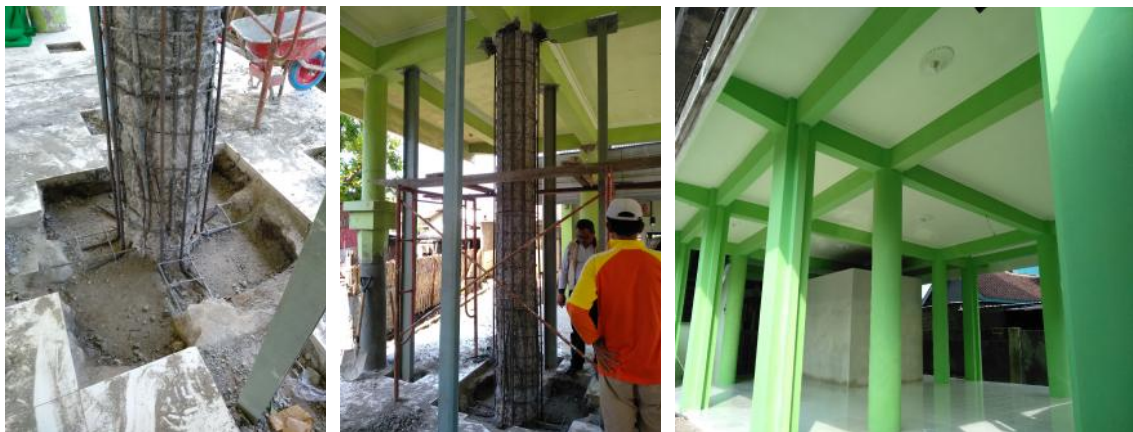
Gambar 4. Perbaikan kolom struktur beton bertulang yang mengalami kerusakan (PT. Indra Karya, 2019)
